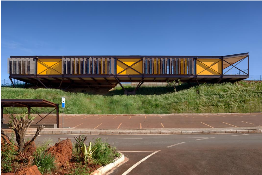
Figura 11: Fachada, Centro de Visitantes do Parque Rola Moça
