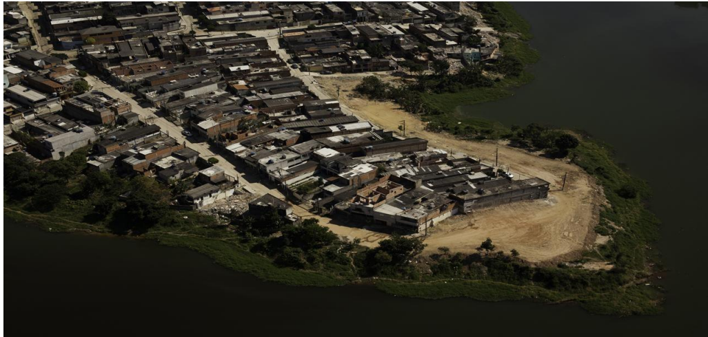
Figura 20: Área limpa após a remoção das construções em risco.
