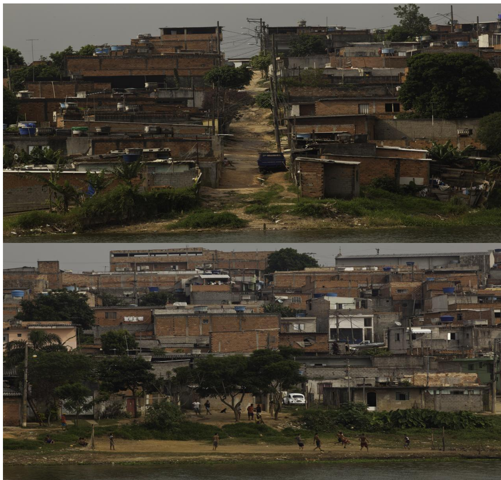
Figura 17: Construções e rua, às margens da represa, antes da intervenção.
