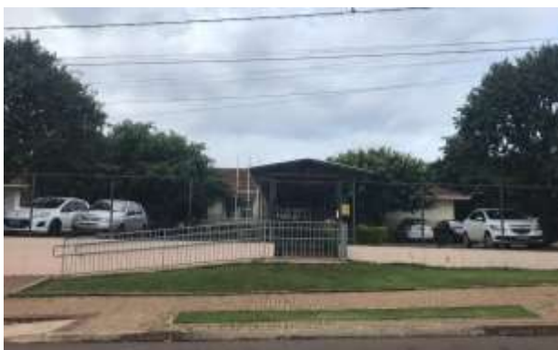
Figura 42 – Fachada principal da escola
