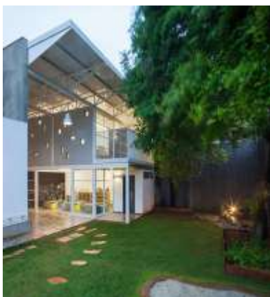
Figura 32 – Pavilhão com cobertura metálica e jardim
