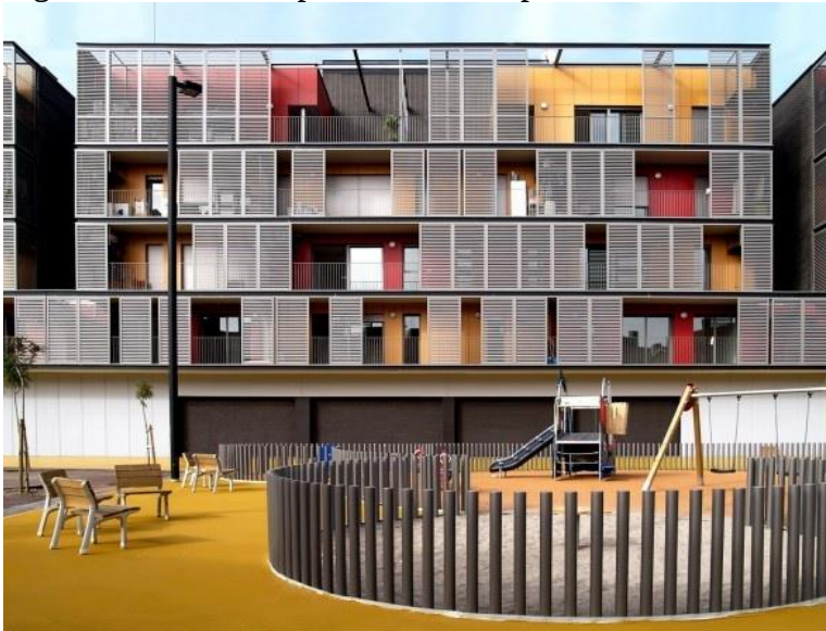
Figura 11 – Fachada para interior do pátio, fachada mais leve, com aberturas e pele de brises.
