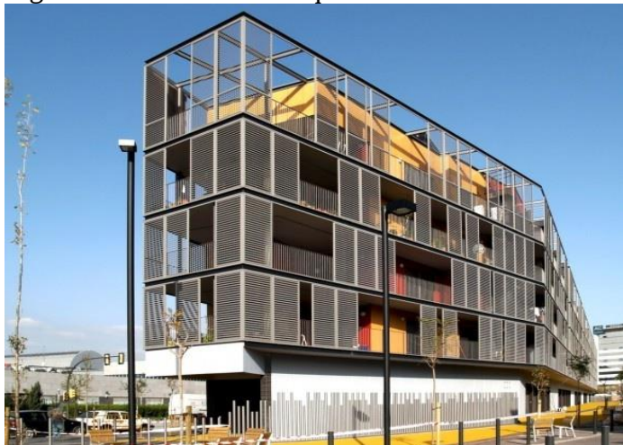
Figura 07 – Fachada de esquina entre a Calle Ciencias e praça interna.
