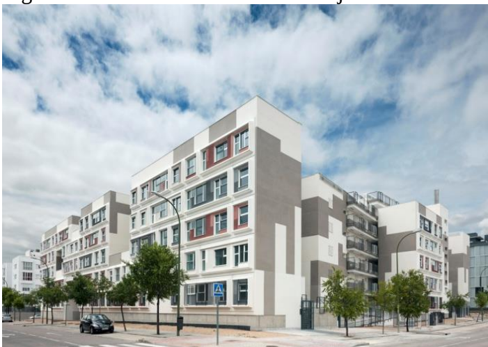
Figura 13 – Fachada do Edifício Barajas.
