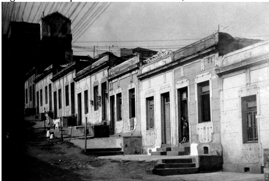
Figura 01 - Cortiço na rua Cardeal Arcoverde, São Paulo.
