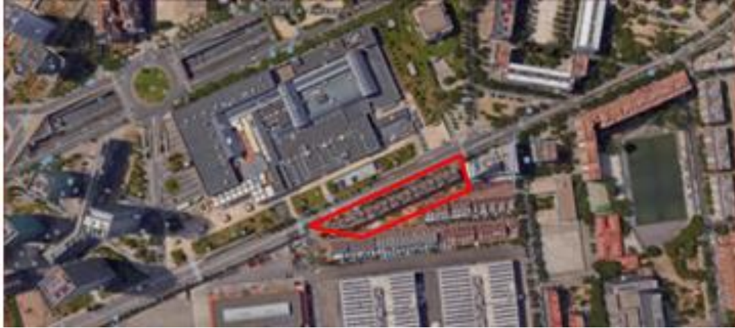
Figura 06 – Vista aérea do Conjunto Habitacional Fira de Barcelona.
