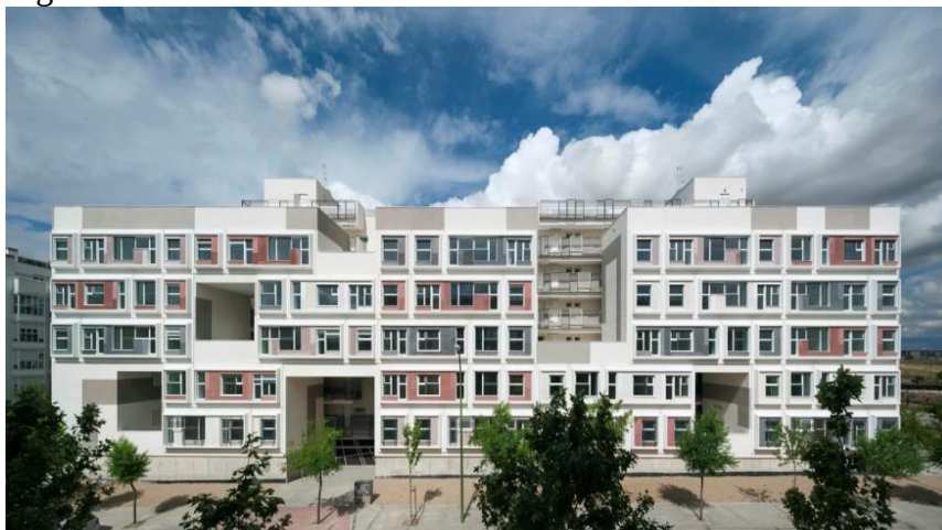
Figura 17 – Fachada vista de dentro do bloco.
