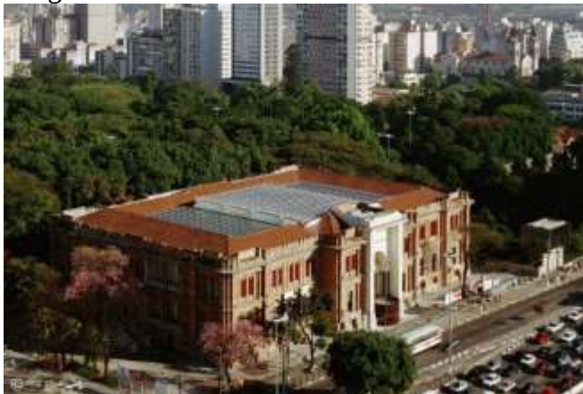
Imagem 01 - Vista aérea da Pinacoteca de São Paulo
