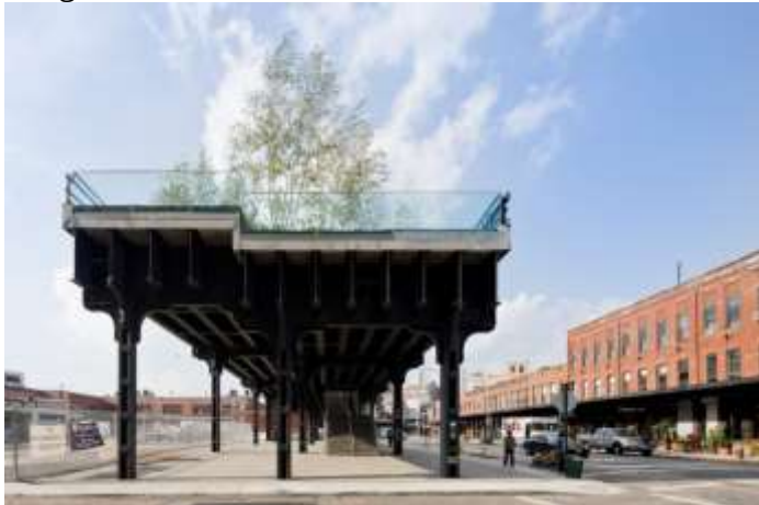
Imagem 03 - Trecho 01 da Escadaria da Gansevoort e Washington Streets
