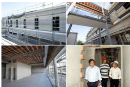
FIGURA 6 - Construção da estrutura para o Lar de Idosos
