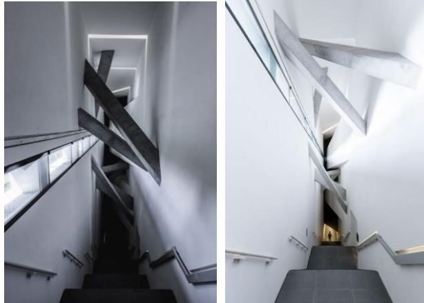
Imagem 11 – Vigas presentes na escadaria do Eixo da Continuidade
