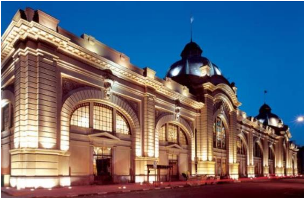
Figura 09: Fachada do Mercado
