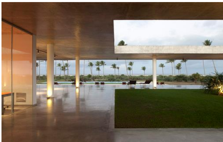
Figura 19: Estrutura Resort Makenna
