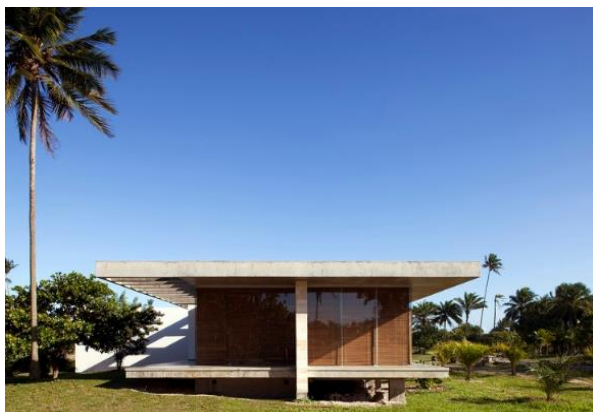
Figura 25: Revestimentos em madeira Resort Makenna
