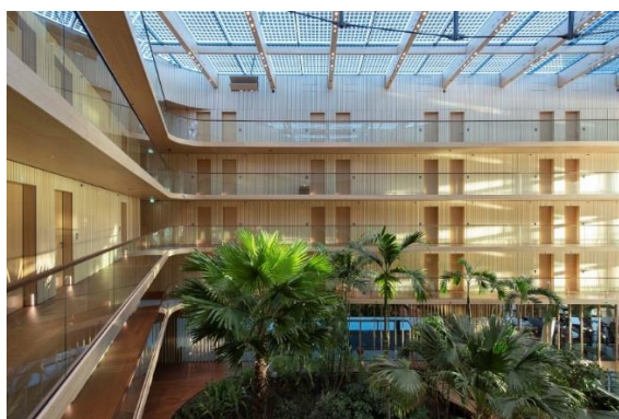
Figura 12 - Blocos pré-fabricados Hotel Jakarta
