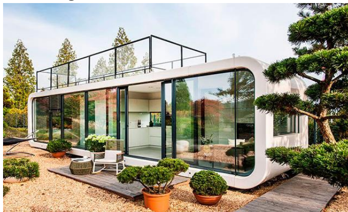
Figura 22. Fachada COODO HOUSE
