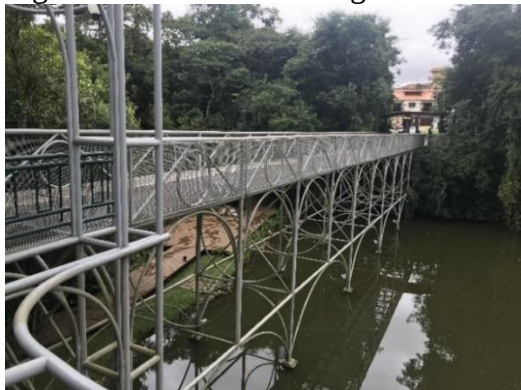
Figura 8 – Ponte sobre o lago.
