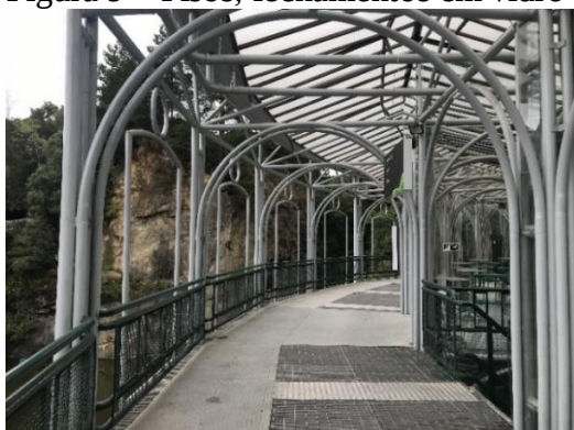
Figura 9 – Pisos, fechamentos em vidro recuado e cobertura em policarbonato.
