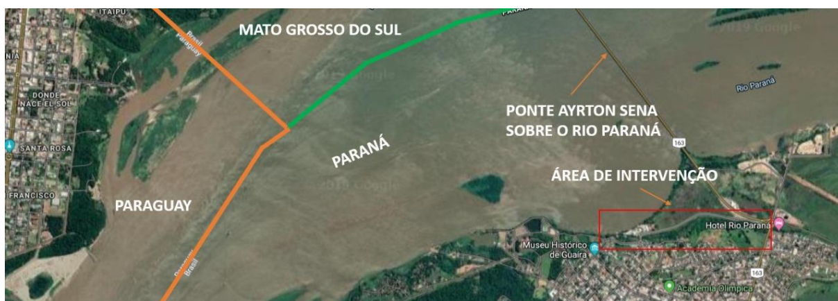
Figura 27: Local de intervenção (Vista Macro)
