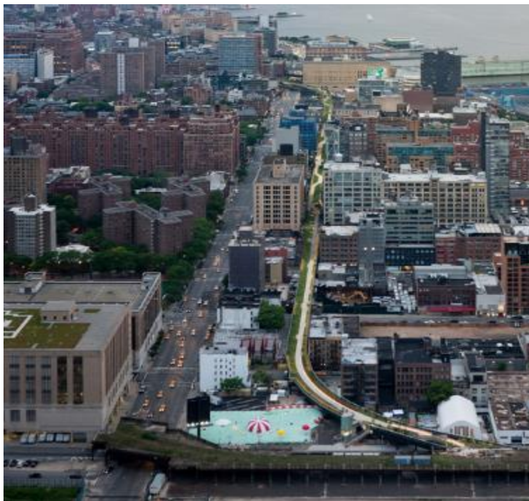
Figura 12: Extensão High Line Park
