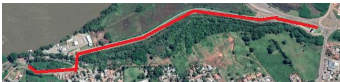
Figura 28: Local de intervenção (Vista Micro)
