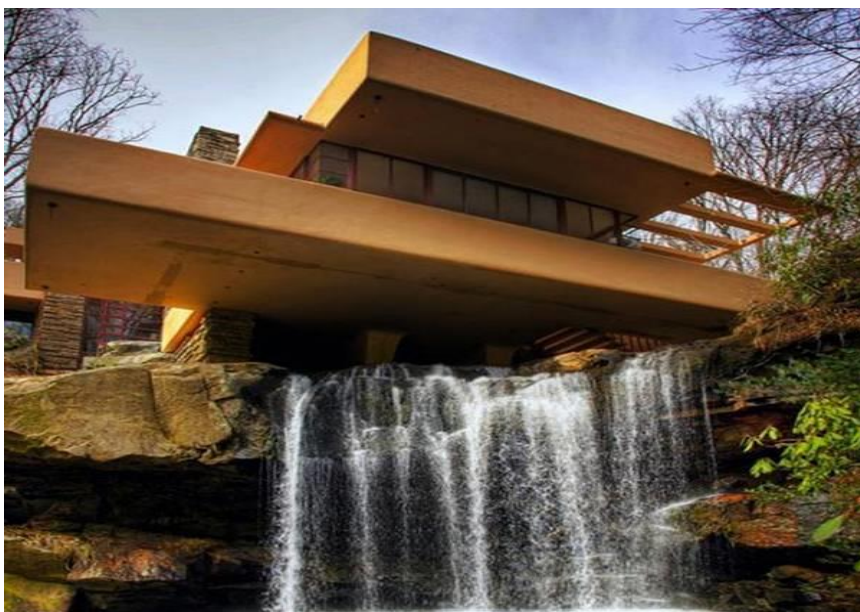
Figura 20: Integração entre a obra e a edificação
