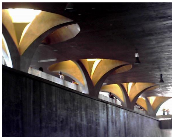
Figura 12 - Detalhe do pilar da rodoviária de Jaú
