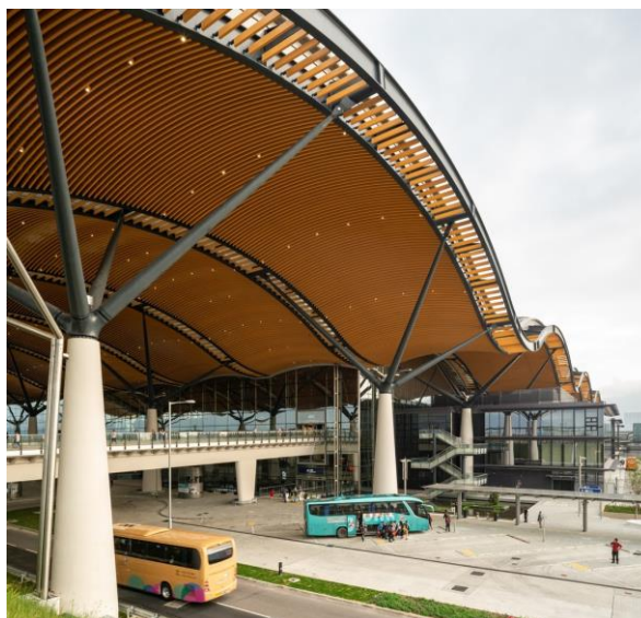
Figura 15 - Terminal de Passageiros PCB
