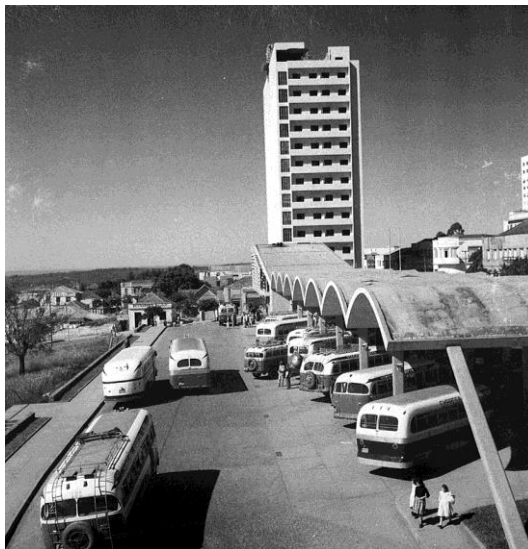
Figura 7 - Abóbodas em concreto armado
