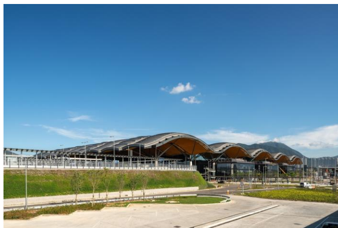
Figura 14 - Terminal de Passageiros PCB
