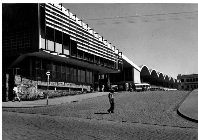
Figura 6 - Terminal Rodoviário de Londrina
