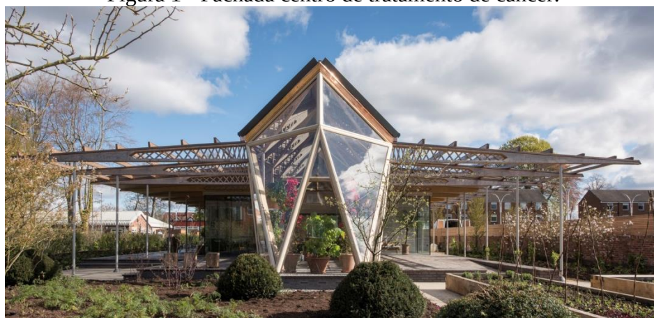
Figura 1 - Fachada centro de tratamento de câncer.
