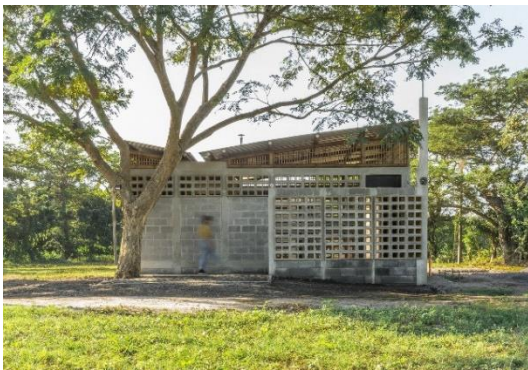
Figura 14: Edificação/ Ventilação Cruzada
