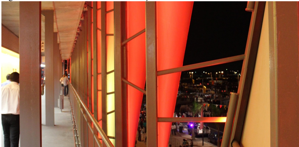
Figura 47 - Sistema de brises com iluminação em LED.
