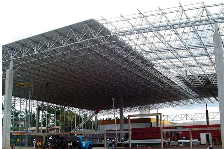
Figura 7 - Estrutura Espacial sendo executada
