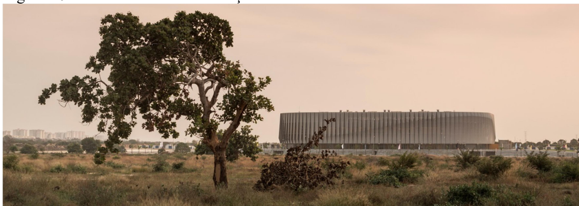
Figura 40 - Vista externa da edificação.
