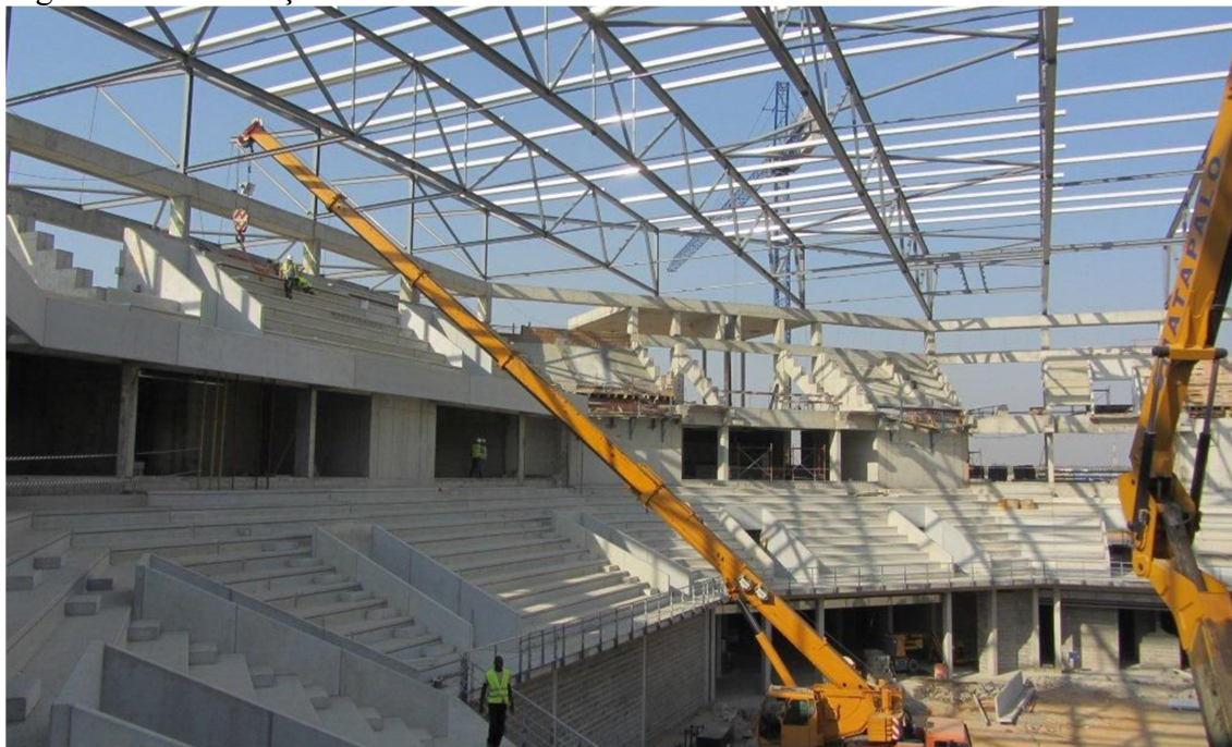
Figura 45 - Construção da arena.
