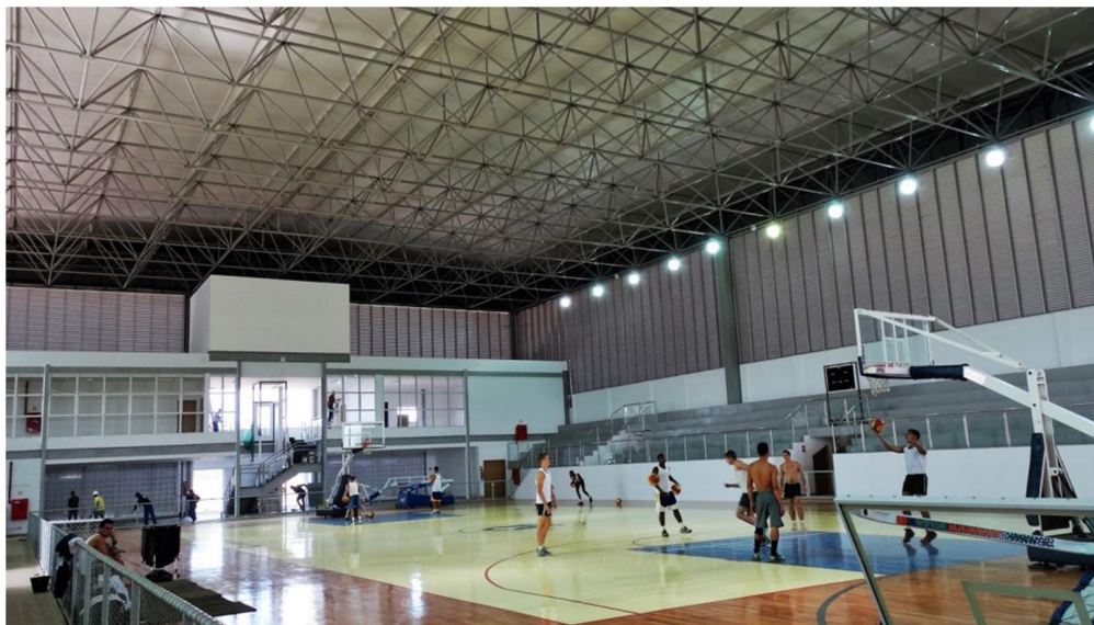
Figura 8 - Estrutura espacial em ginásio
