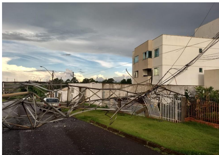
Figura 17: Torres derrubadas por ventos fortes no município.
