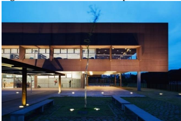
Figura 09. Vista fachada com placas de concreto.
