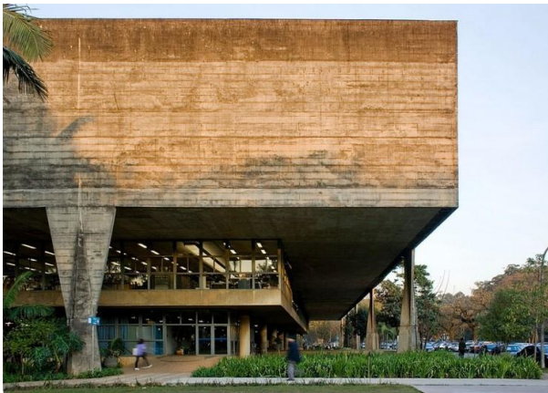
Figura 5. Concreto armado aparente.
