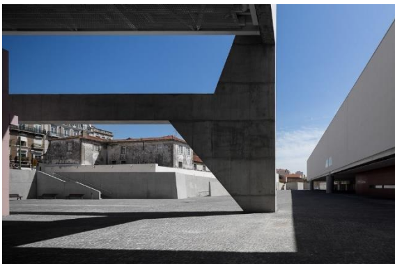
Figura 14. Estrutura do pilar edifício anexo.
