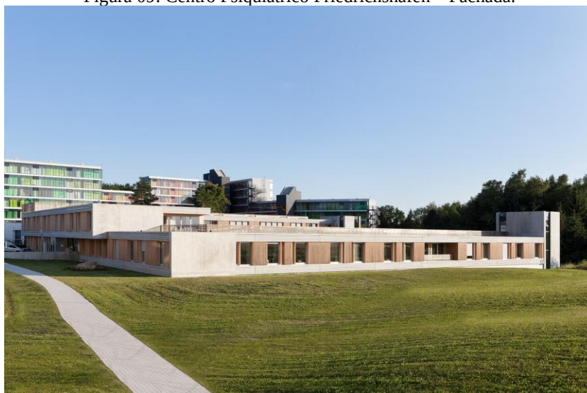
Figura 09: Centro Psiquiátrico Friedrichshafen – Fachada.
