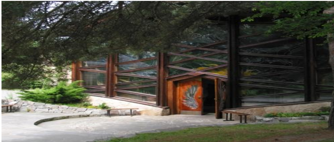
Figura 16 Centro de eventos
