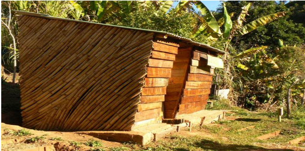
Figura 29 Construção em Bambu
