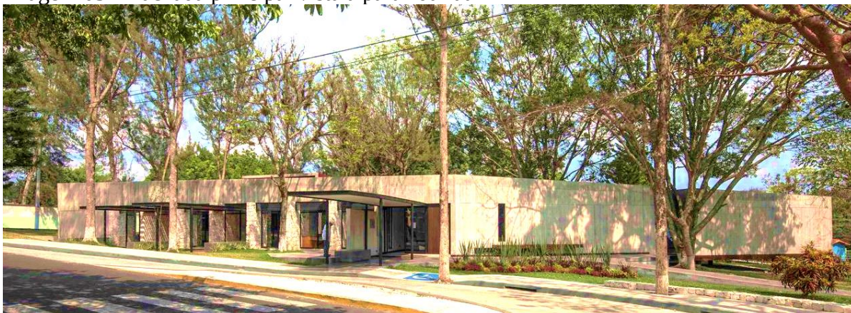
Imagem 05 – Fachada principal vista a partir da rua
