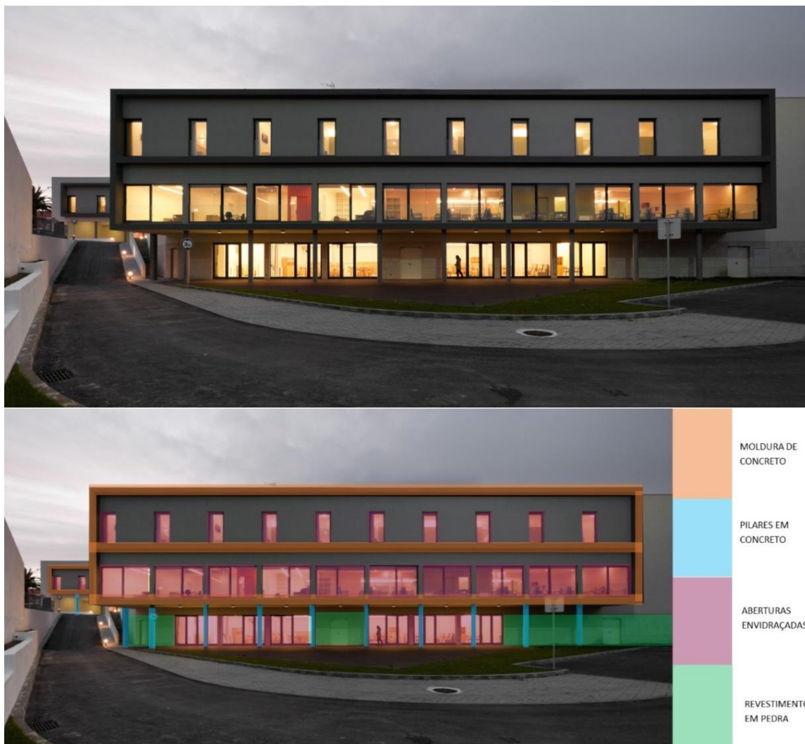
Figura 9 - Materiais na fachada principal.
