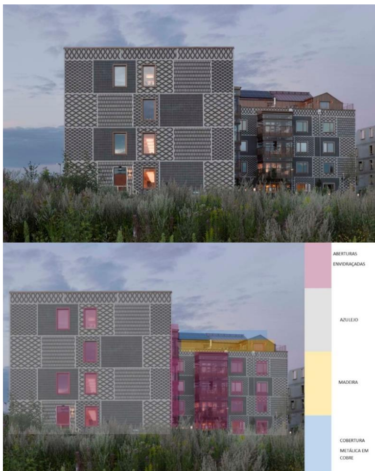
Figura 22 - Materiais na fachada.
