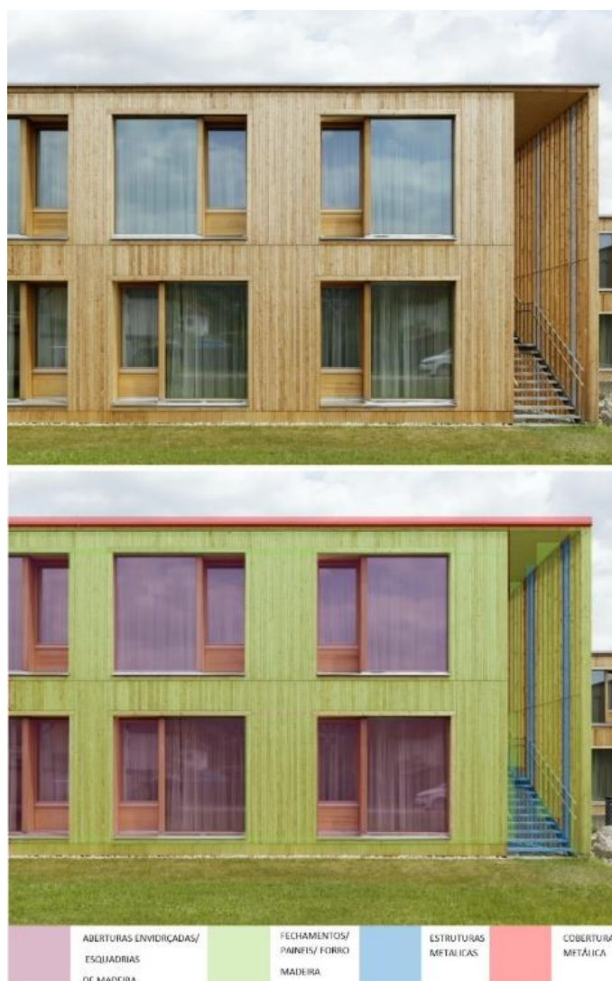
Figura 34 - Materiais na fachada.
