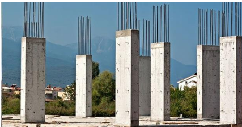
Figura 11 – Estrutura em concreto armado
