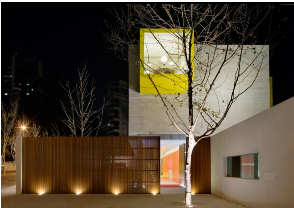
Figura 40: Fachada lateral com blocos
