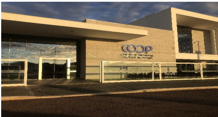
Figura 41: Entorno do terreno – Edificações do entorno
