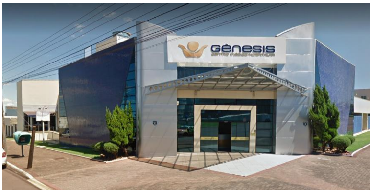
Figura 42: Entorno do terreno – Edificações do entorno
