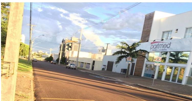
Figura 43: Entorno do terreno – Edificações do entorno
