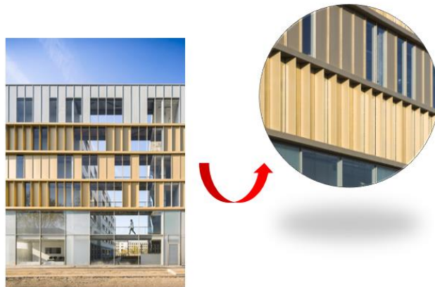
Figura 09: Detalhamento do brise.
