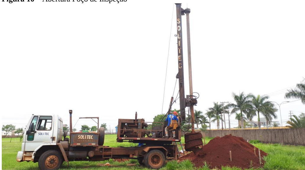
Figura 10 – Abertura Poço de Inspeção
