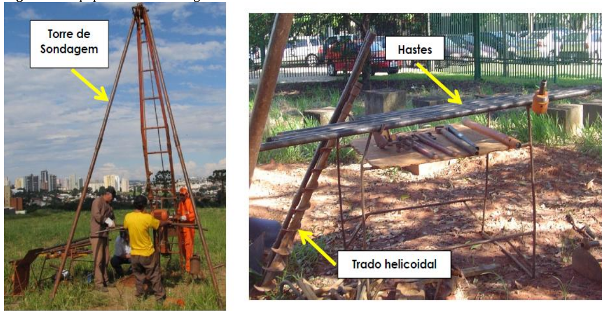
Figura 4 – Equipamento de Sondagem SPT
