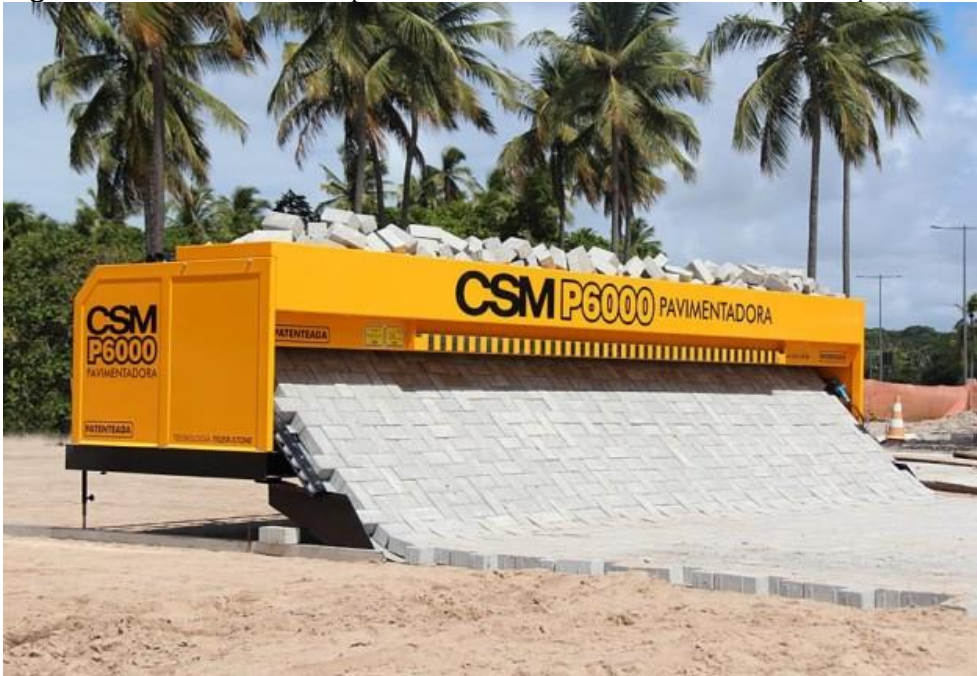
Figura 03: Assentamento de pavimento intertravado com auxílio de máquina.
