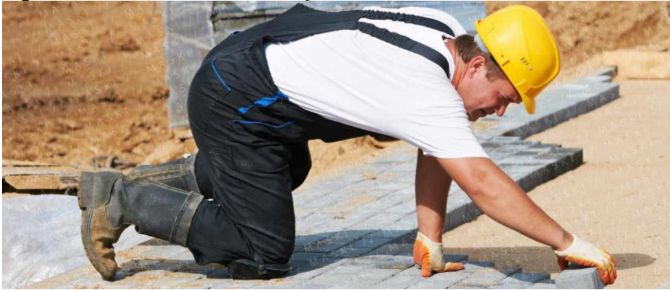
Figura 02: Assentamento manual de pavimento intertravado.
