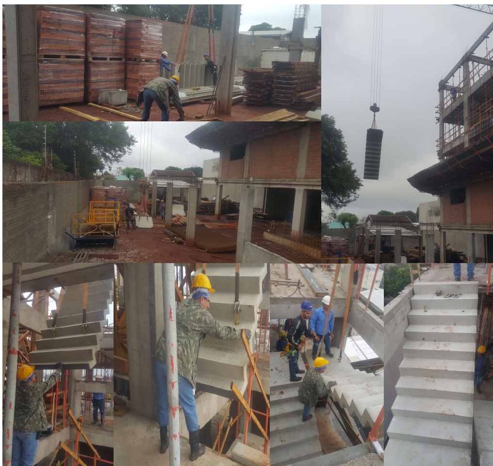
Figura 31: Aspectos construtivos: Manuseio e montagem da escada pré-fabricada.
