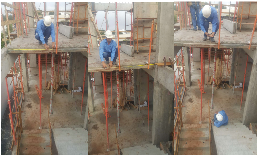
Figura 29: Aspectos Construtivos: Marcação da escada pré-fabricada.
