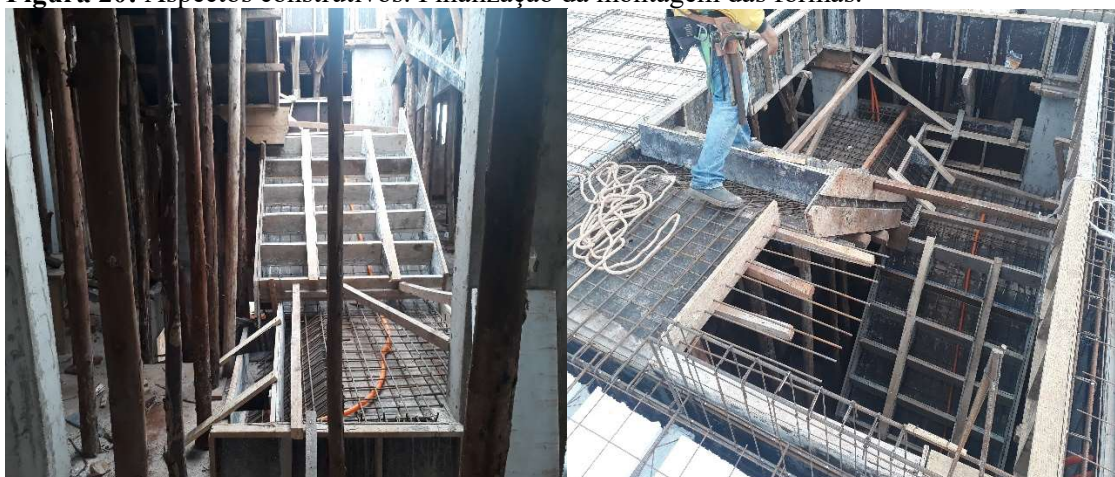
Figura 20: Aspectos construtivos: Finalização da montagem das fôrmas.
