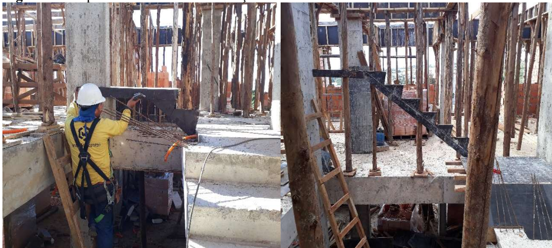
Figura 18: Aspectos construtivos: Marcação da escada moldada in loco .
