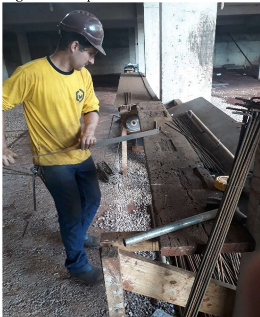
Figura 22: Aspectos construtivos: Dobramento do aço.
