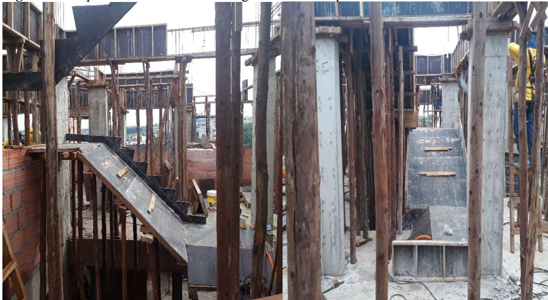
Figura 19: Aspectos construtivos: Montagem das fôrmas para escada moldada in loco .
