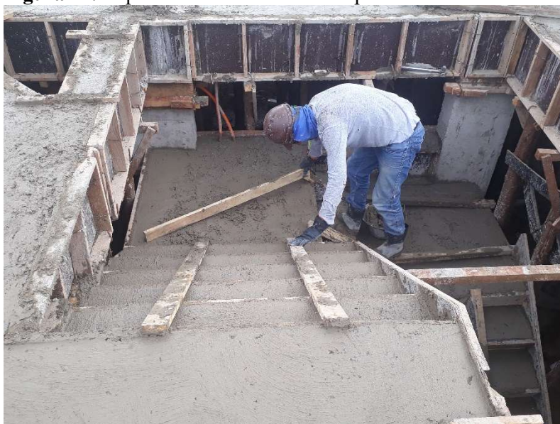
Figura 27: Aspectos construtivos: Desempenamento do concreto.
