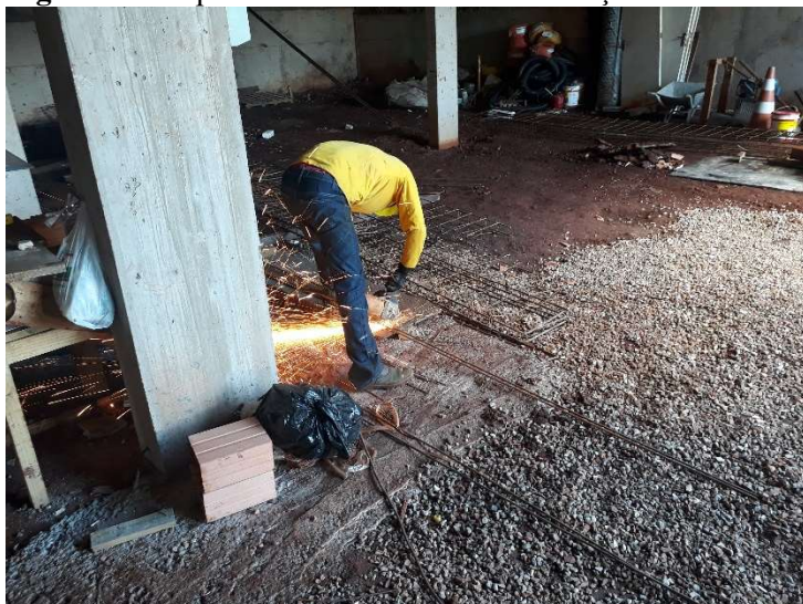
Figura 21: Aspectos construtivos: Corte do aço.
