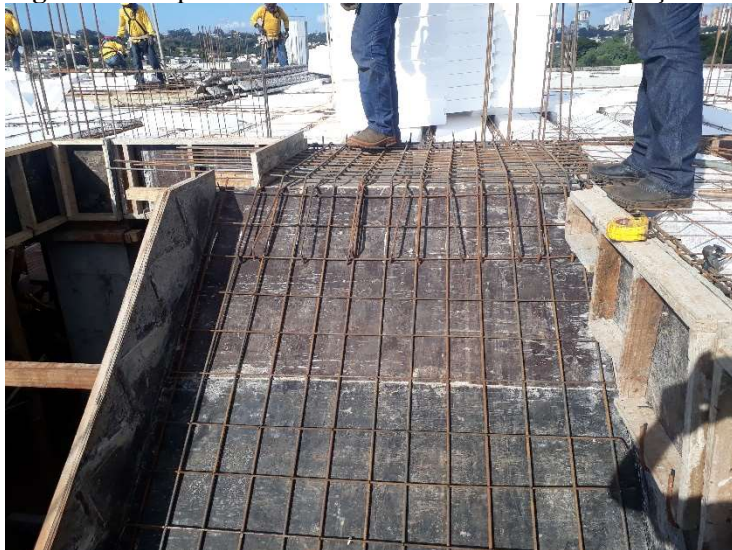
Figura 25: Aspectos construtivos: Inexistência de espaçadores.
