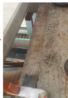
Figura 61: Comparação entre as amostras: Ligação e juntas executado na obra.
