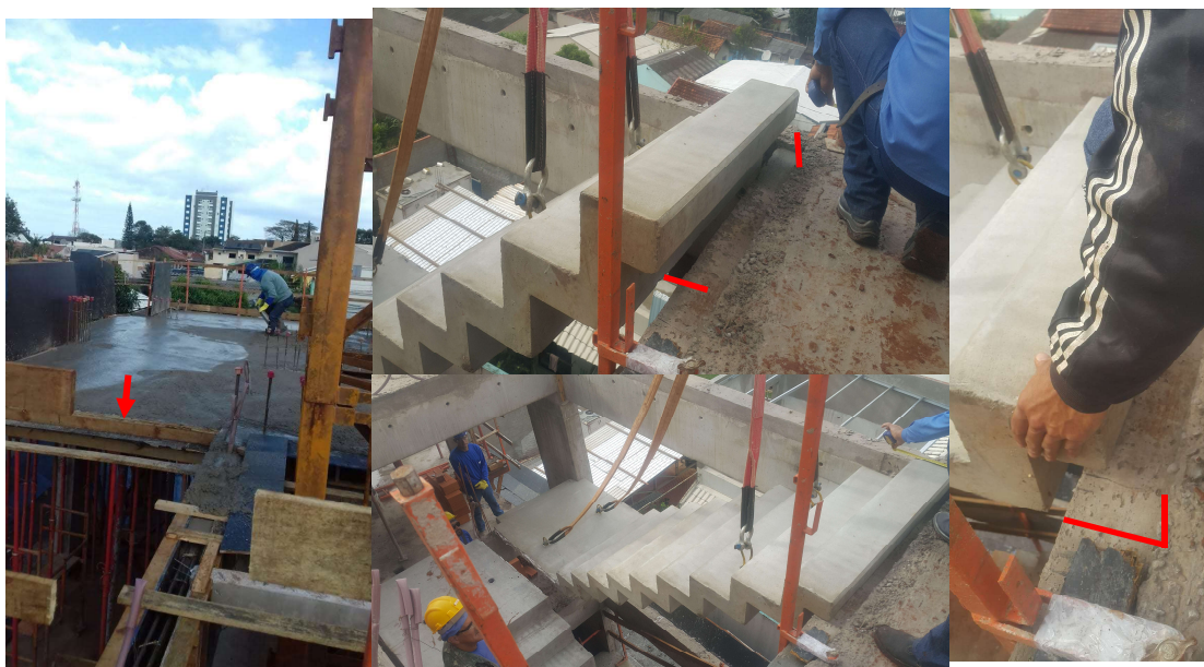
Figura 64: Comparação entre as amostras: Execução do sistema de encaixe.
