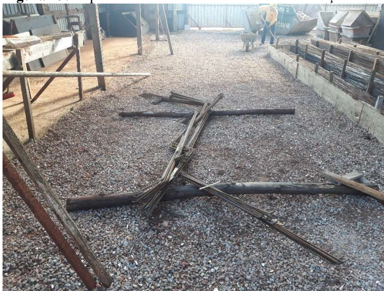
Figura 23: Aspectos construtivos: Kits das barras de aço.
