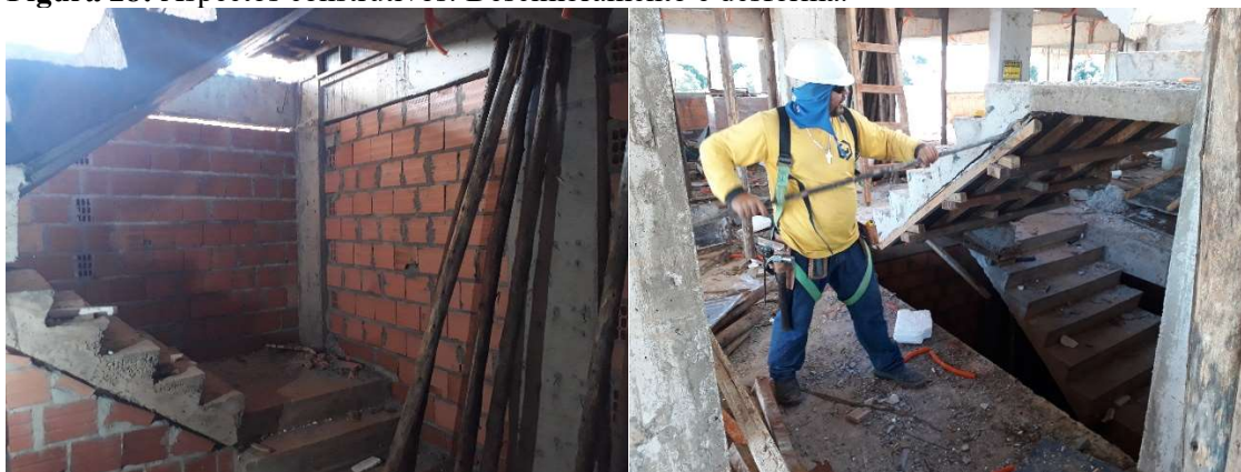
Figura 28: Aspectos construtivos: Descimbramento e desforma.
