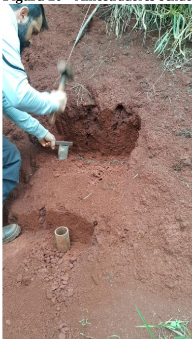
Figura 20 - Amostradores sendo cravados no solo.
