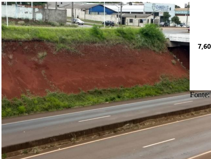
Figura 14 – Talude junto a BR 467/Pacaembu.
