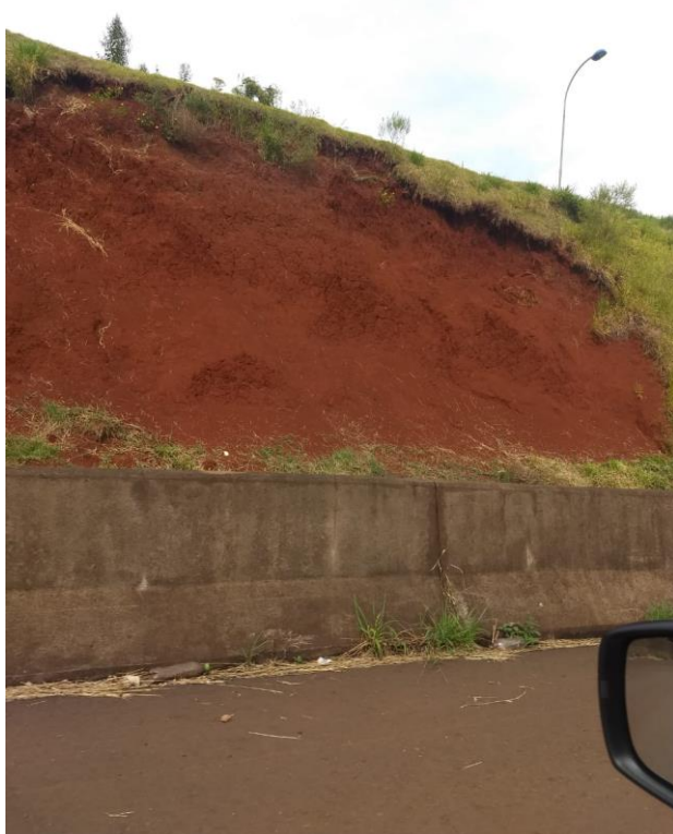
Figura 17 – Talude junto a BR467/Canadá.
