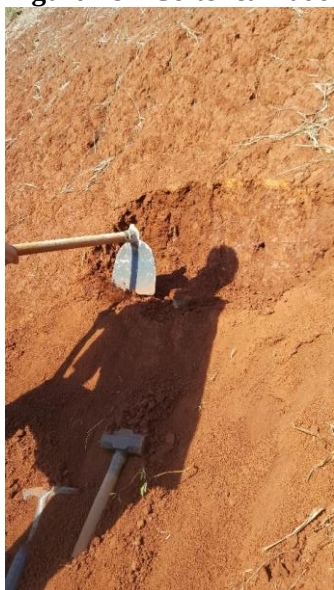
Figura 19 - Corte realizado no talude.
