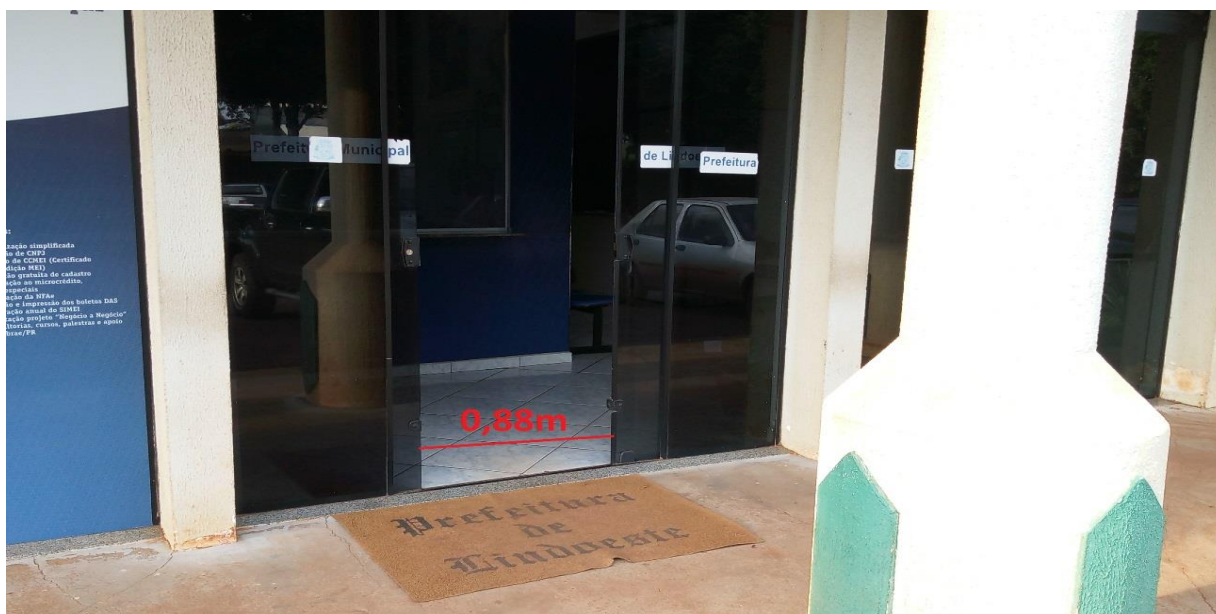
Figura 22: Porta da entrada principal.
