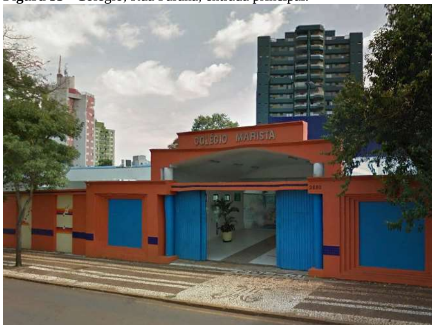
Figura 35 - Colégio, Rua Paraná, entrada principal.
