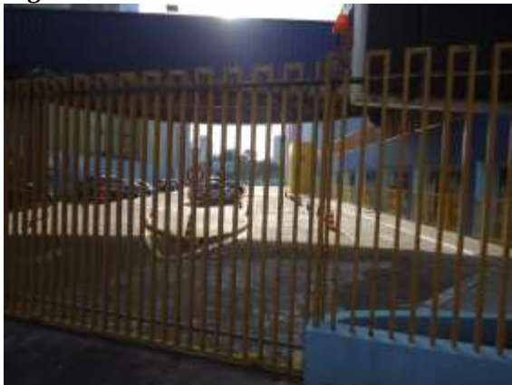
Figuras 45 - Vista 1 do estacionamento.
