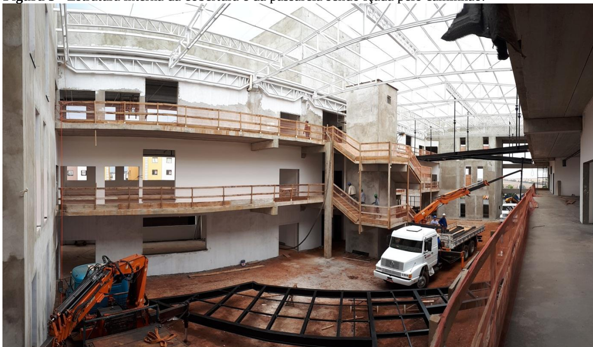
Figura 5 - Estrutura interna da cobertura e da passarela sendo içada pelo caminhão.
