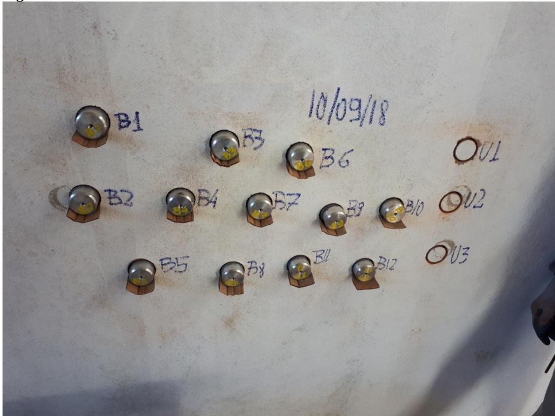
Figura 7 - Teste de arrancamento.
