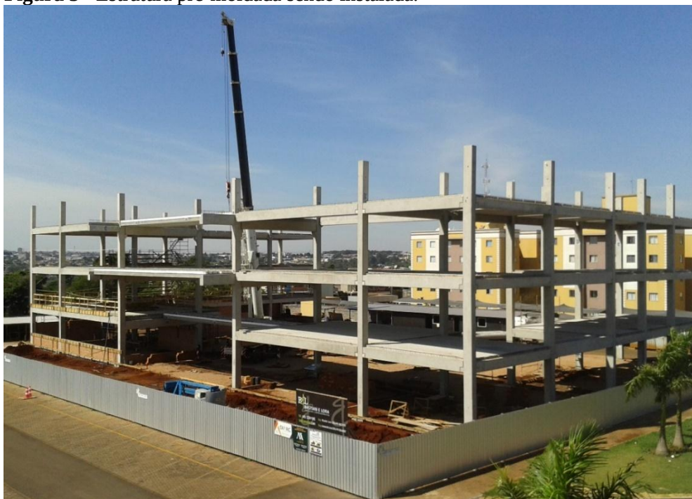
Figura 3 - Estrutura pré-moldada sendo instalada.
