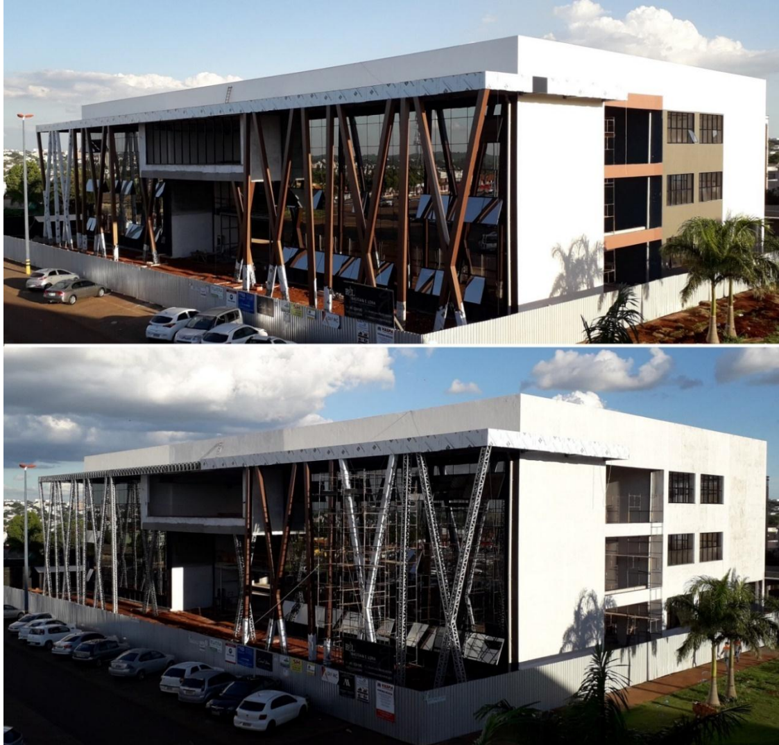
Figura 9 - Fachada da obra, colunas de metal e revestidas em chapas de alumínio composto.
