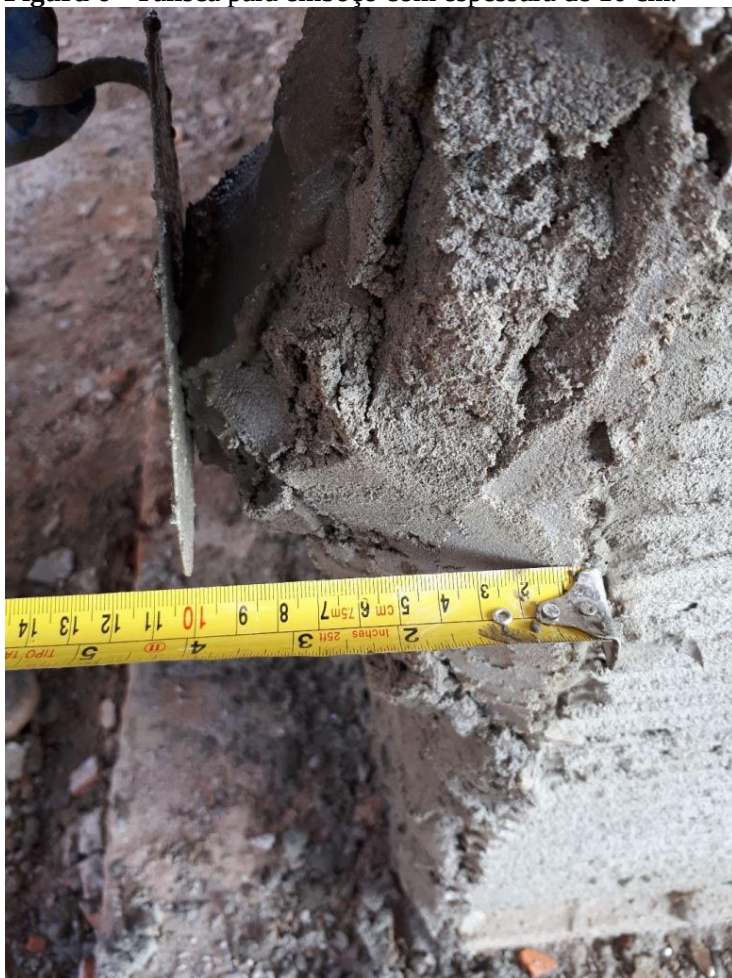
Figura 6 - Talisca para emboço com espessura de 10 cm.
