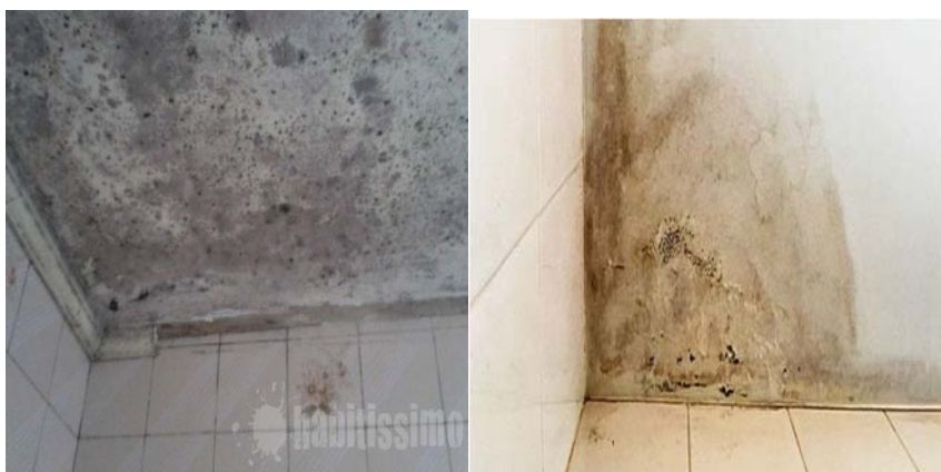
Figura 05: Formação de bolor decorrente de umidade
