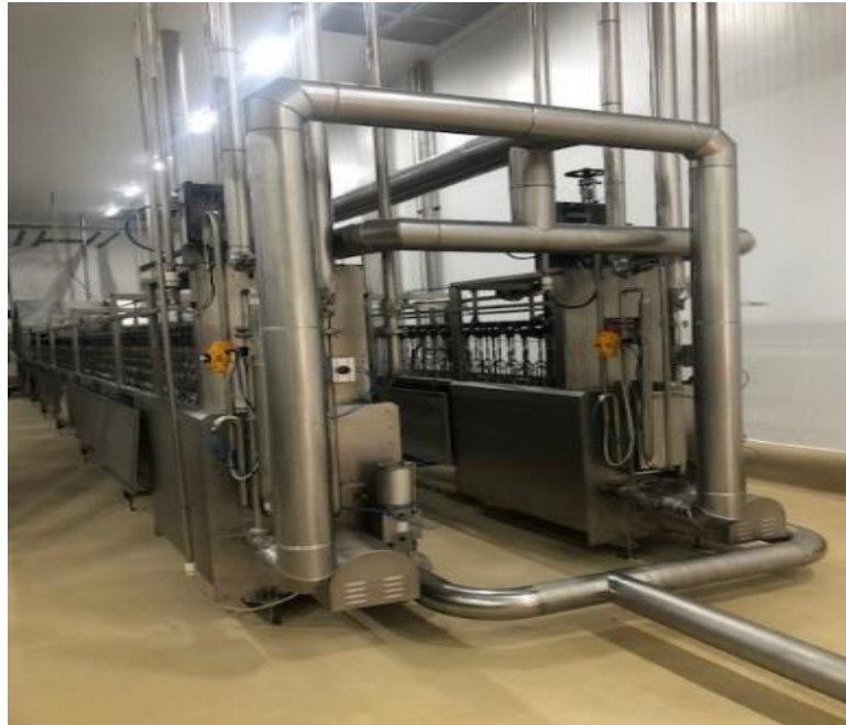
Figura 04: Tanque de escaldagem
