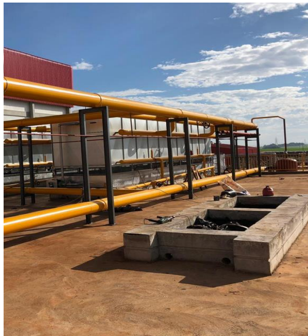
Figura 28: Espaço físico para o novo condensador
