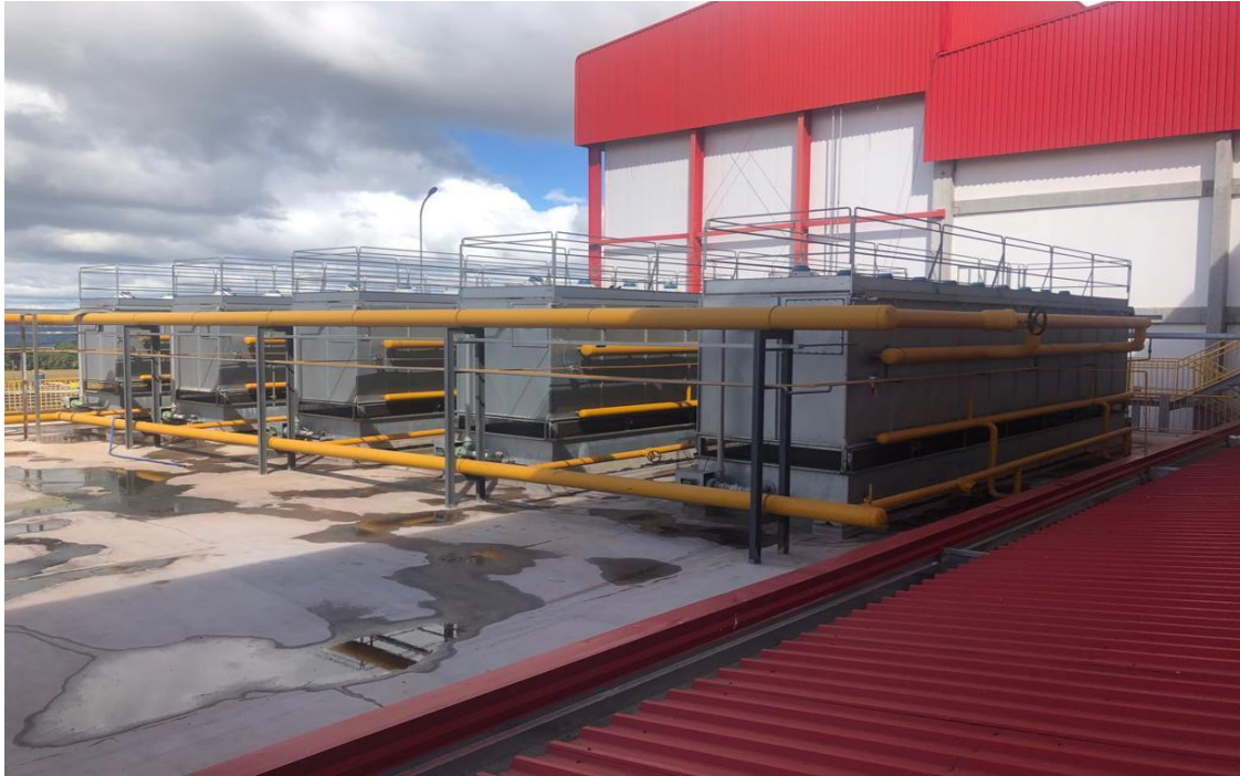
Figura 17: Condensadores evaporativos
