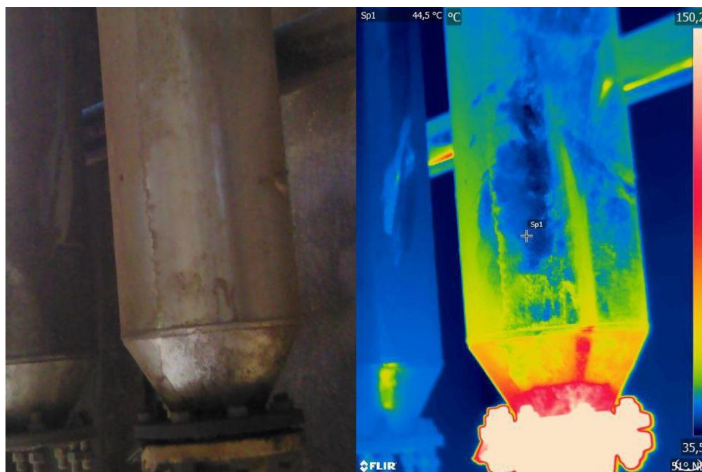
Figura 6: Isolamento com lã de rocha: 44,5 °C
