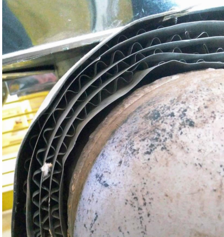
Figura 8: Partições do isolamento instalado
