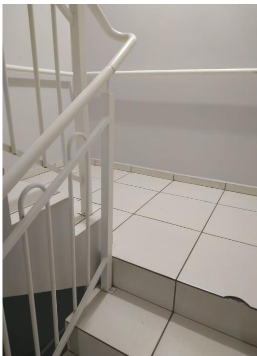
Figura 9: Escada com lances adjacentes (Fonte: Autora, 2019).
