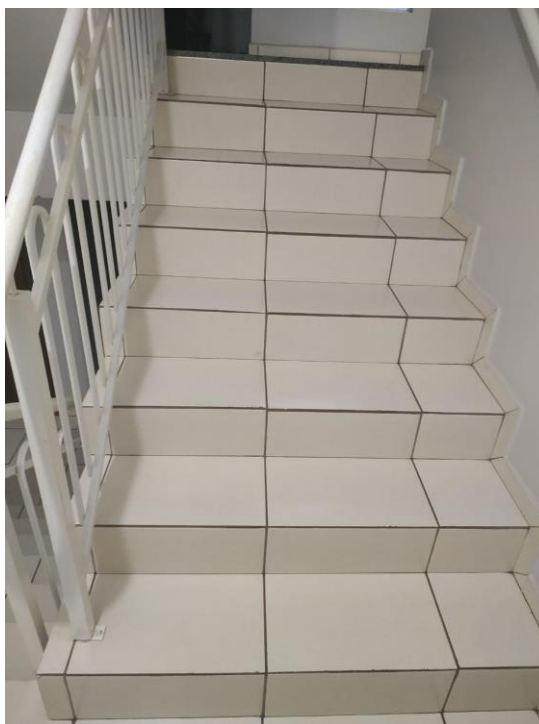
Figura 10: Escada com lances adjacentes
