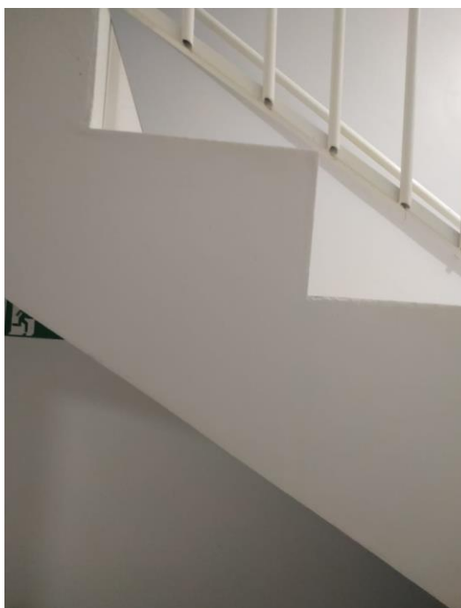
Figura 11: Escada com lances adjacentes
