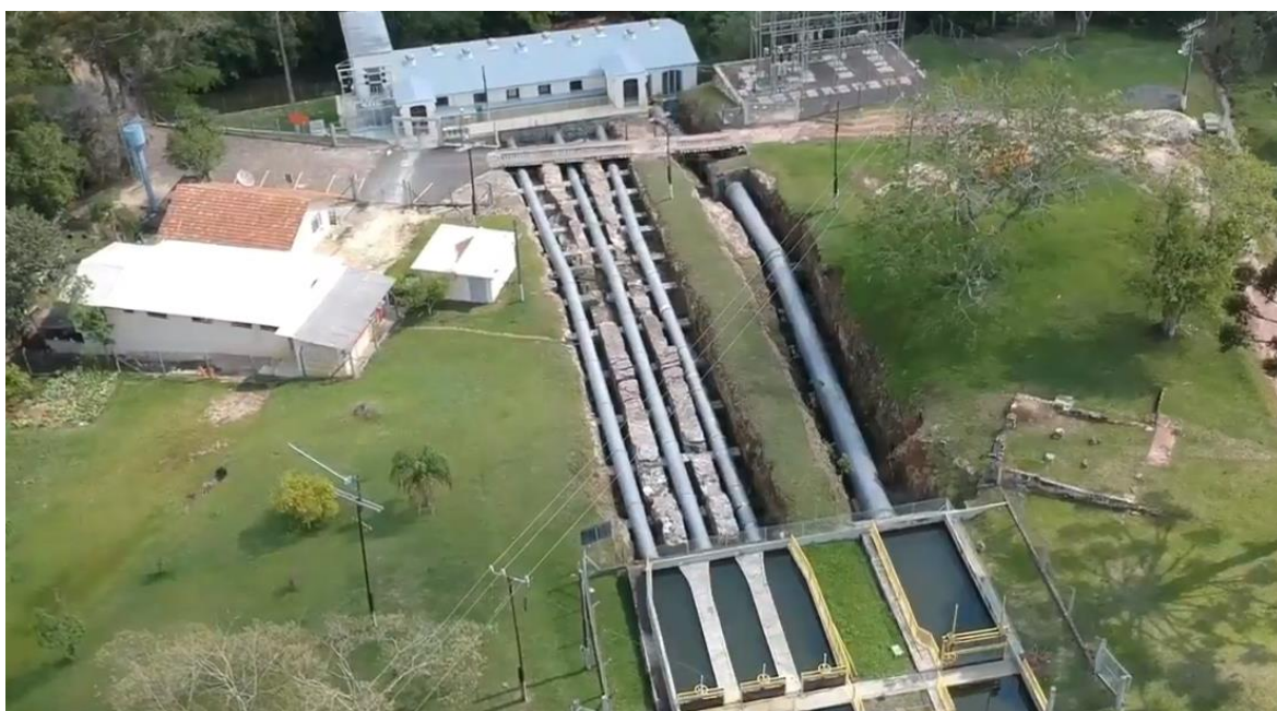
Figura 20: Usina e condutos.
