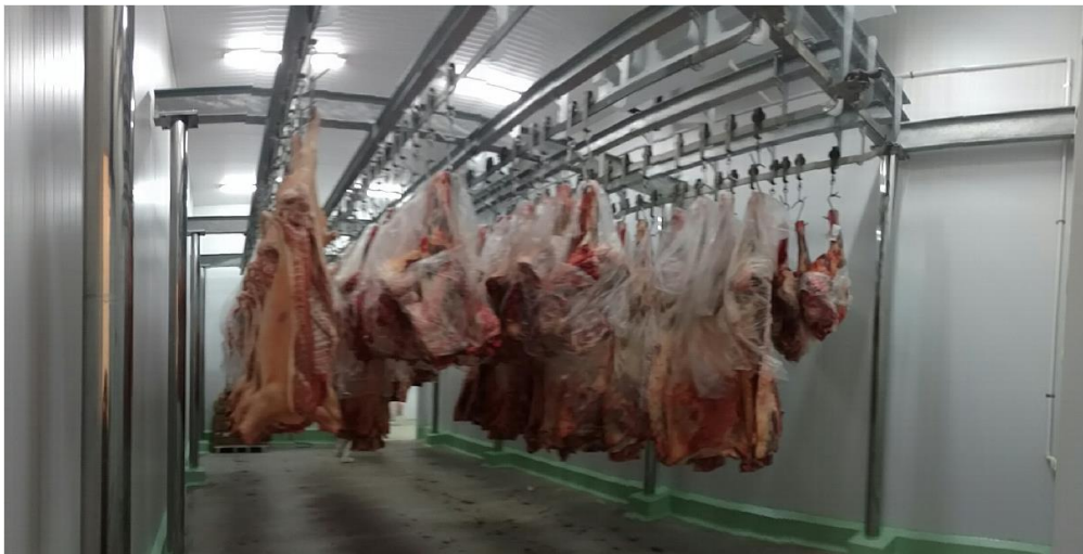
FIGURA 19: Visão Geral da parte interna Câmara Frigorífica
