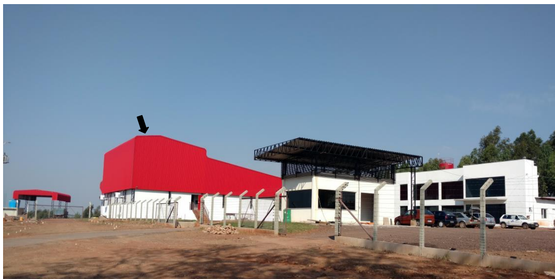
FIGURA 14: Fachada do Frigorífico
