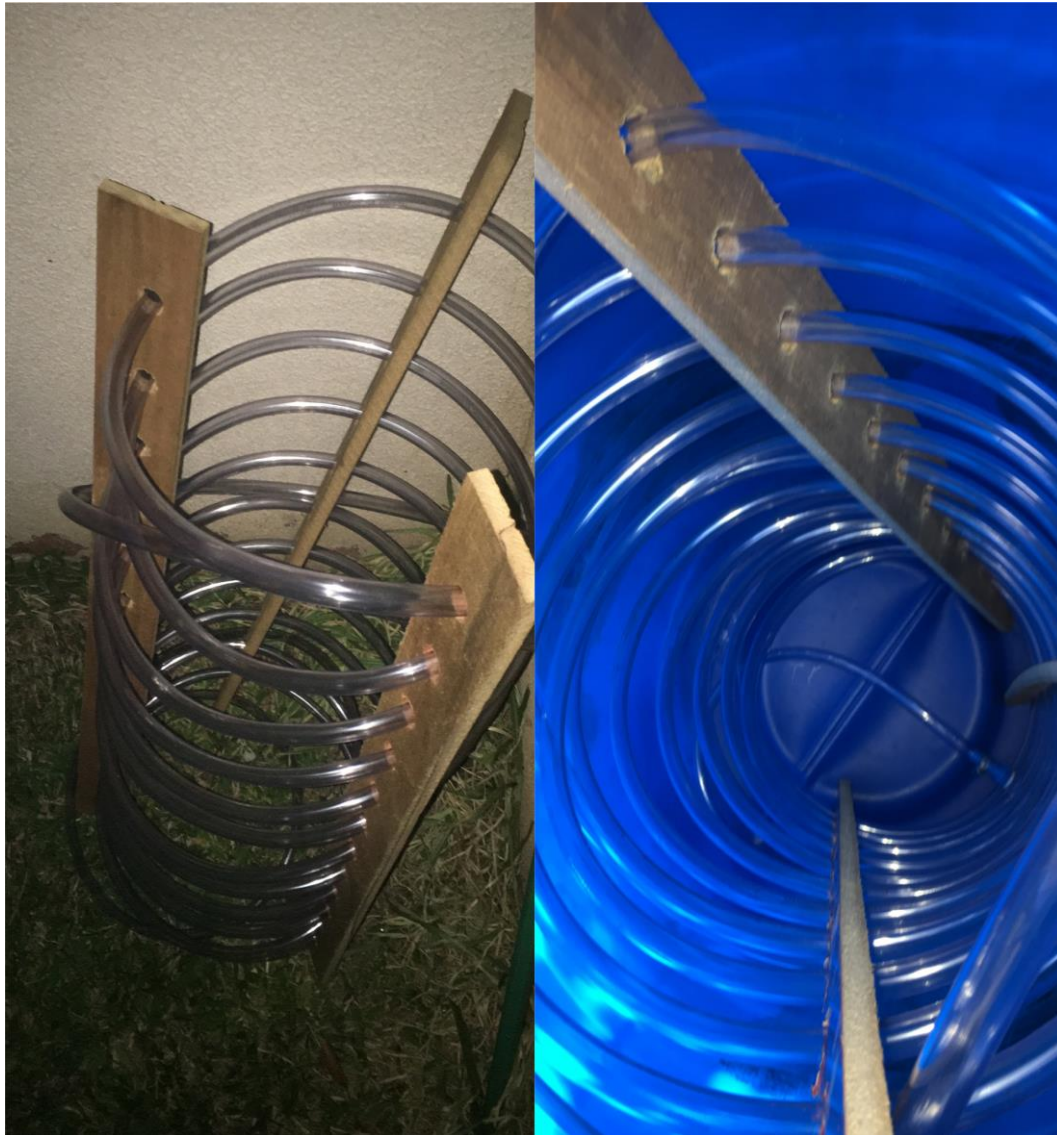
Figura 08 - Elaboração e implantação da serpentina de aquecimento
