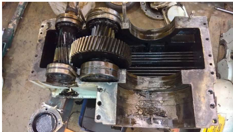
Figura 4: Redutor desmontado para troca de rolamentos
