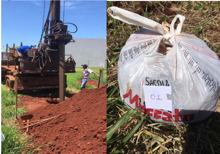
Figura 12: Poço de inspeção no CEEF e armazenamento em sacos plásticos.
