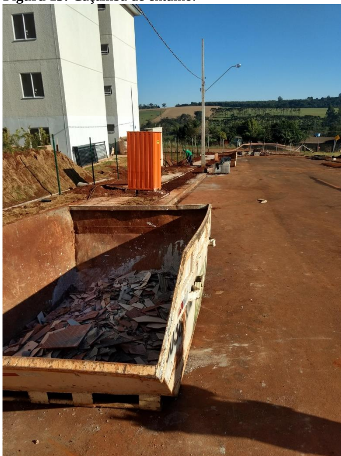
Figura 13: Caçamba de entulho.
