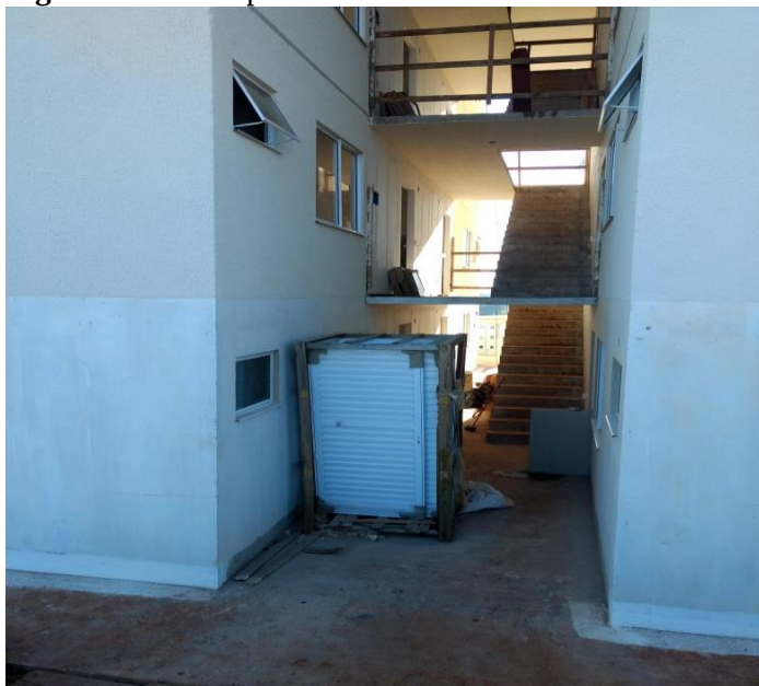
Figura 18: Portas para serem instaladas.
