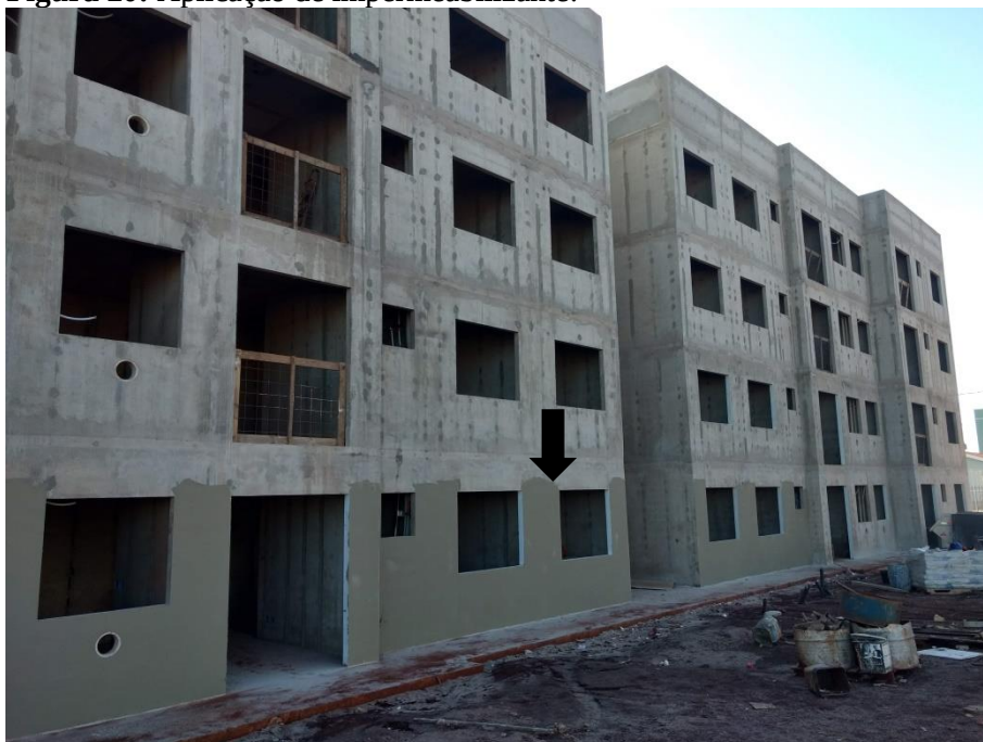
Figura 20: Aplicação de impermeabilizante.
