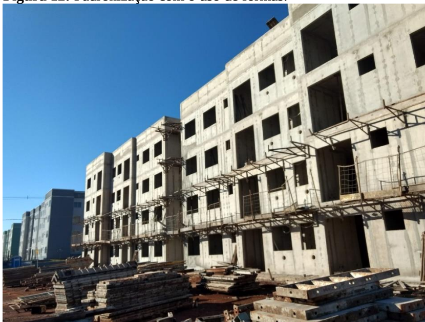
Figura 12: Padronização com o uso de formas.
