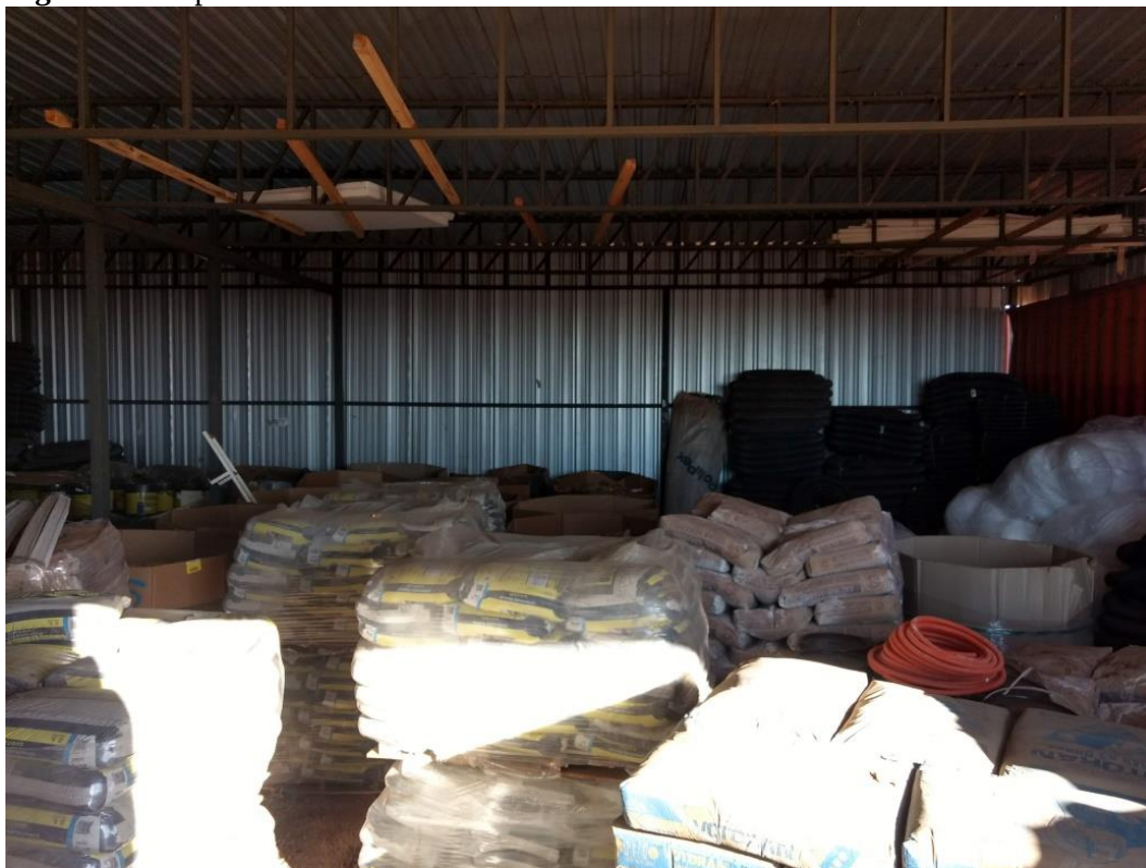
Figura 19: Depósito de materiais.
