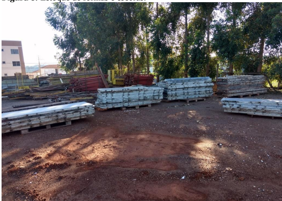
Figura 8: Estoque de formas e escoras.
