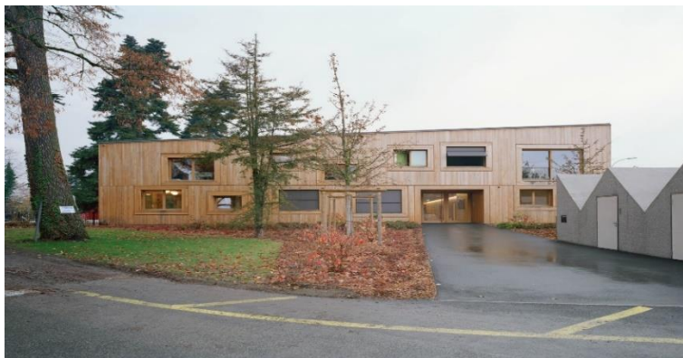
Figura 02 – Fachada Frontal, Jardim de Infância
