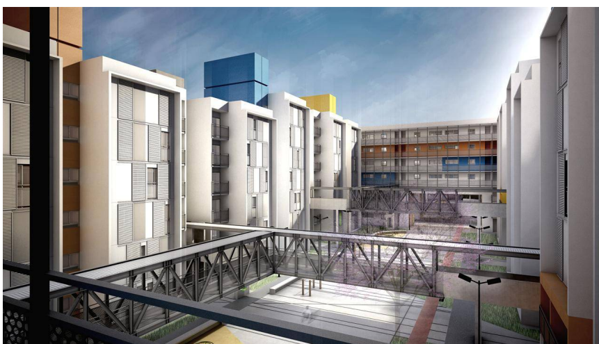
Figura 9: Passarelas em estrutura metálica.
