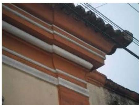
Figura 19: Detalhe cimalha. Fonte: A autora, 2012.
