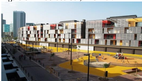
Figura 01 – Fachada Sul, informal.
