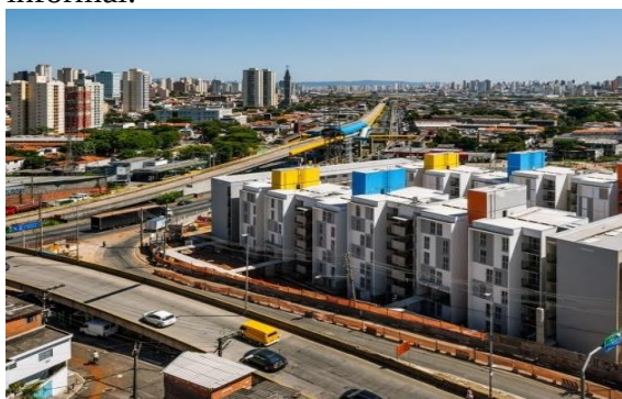
Figura 08 – Conjunto Heliópolis – Gleba G informal.
