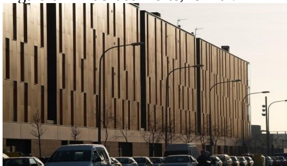
Figura 02 – Fachada Norte, formal.
